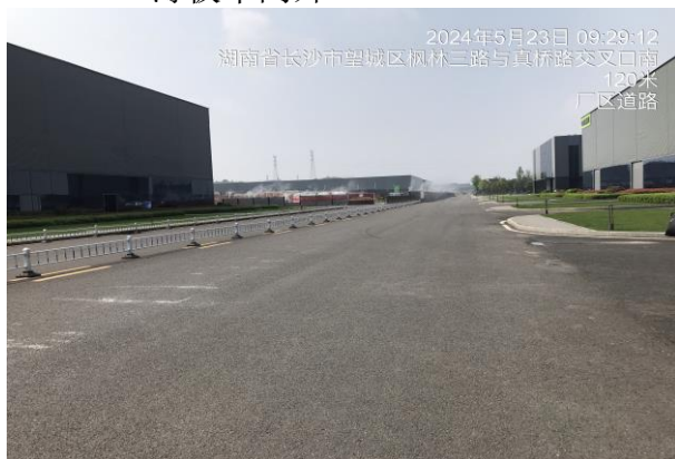
厂区内除绿化带外全部硬化
