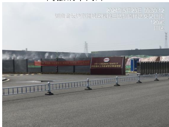
微小挖结构件厂房正在建设(土方公司)
